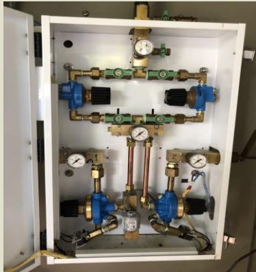
ชุด Regulator ชุดลดแรงดัน ปรับลดแรงดัน 2 ครั้ง 2000 psi >> 150-200 psi >> 50 psi
