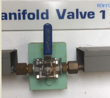
Ball Valve รับความดัน ได้ 1000 psi
